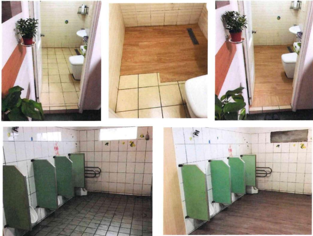
圖集 17-廁所地面乾式施工法
