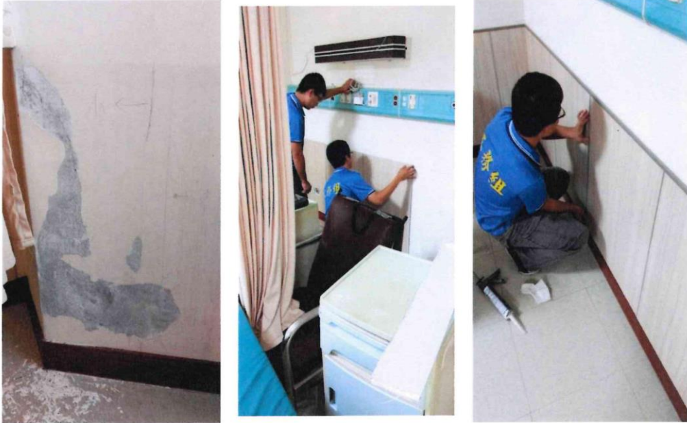
圖集 18-牆面裝飾板乾式施工法
