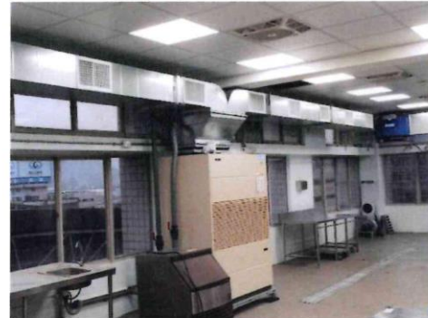
圖 16-箱型冷氣加裝風管側吹改善溫差死角
