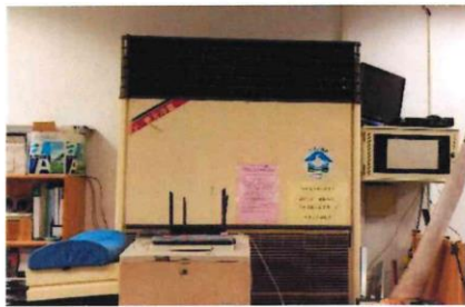
圖集 10-水管老舊、箱型冷氣易有溫差死角
