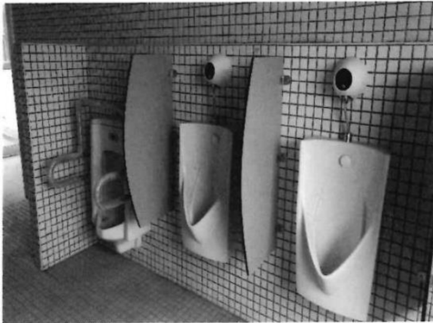
圖 17-衛生設備整修更新
