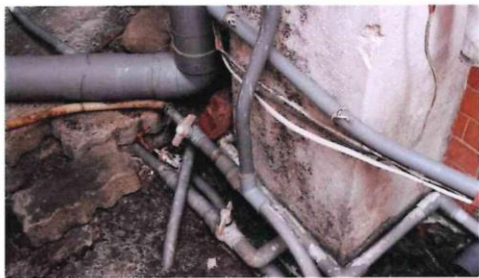
圖集 9-內部電纜線、管線、線路及空間凌亂
