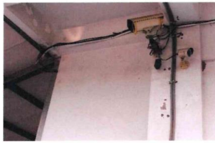
圖集 9-內部電纜線、管線、線路及空間凌亂
