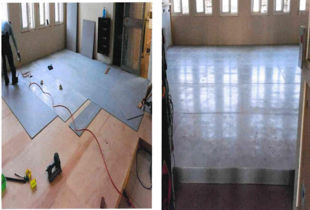
圖集 19-架高地板乾式施工法
