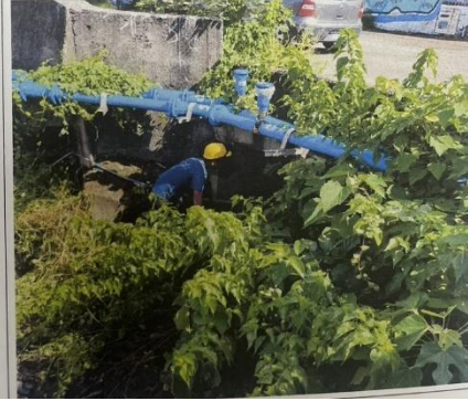
南世文健站後方大排水溝清淤 施工中
