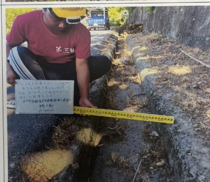
和平往部落主線幹道側溝清淤 施工中
