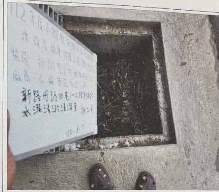
施工前 新路部落丹路四巷11號道路排水溝清淤
