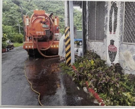
施工中 雙流部落草埔六巷雙側水溝清淤暗溝清溝車
