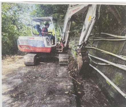
神鷹山產業道路側溝清淤 施工中
