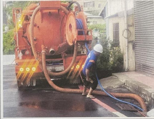
內獅巷100號前排水溝清淤暗溝清溝車 施工中
