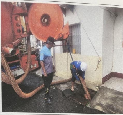
內獅巷100號排水溝清淤暗溝清溝車 施工中
