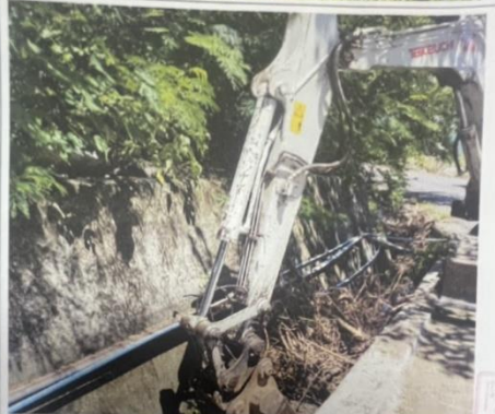
楓林二巷農路側溝清淤 施工中
