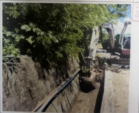
楓林二巷農路側溝清淤 施工中
