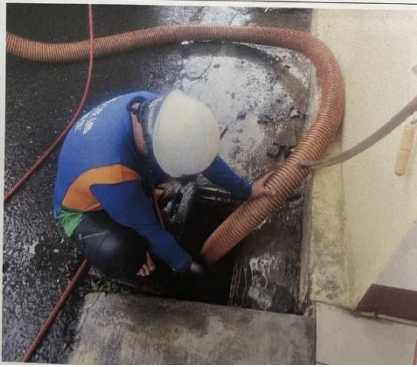
內獅巷100號排水溝清淤暗溝清溝車 施工中
