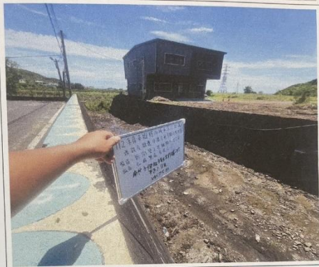
南世文健站後方大排水溝清淤 施工後
