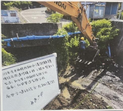
南世文健站後方大排水溝清淤 施工中
