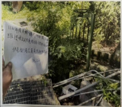
伊屯部落丹路二巷公墓前沉砂池清淤 施工前
