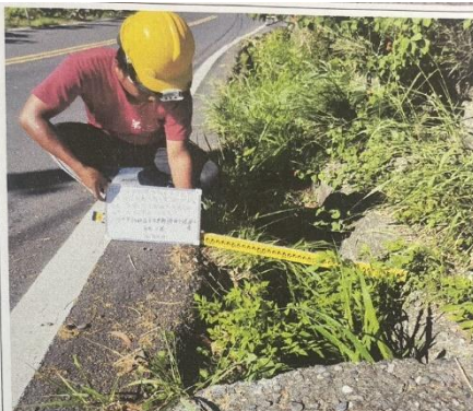
和平往部落主線幹道側溝清淤 施工前
