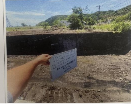
南世文健站後方大排水溝清淤 施工後
