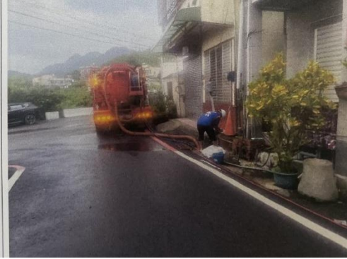
內獅巷100號前排水溝清淤暗溝清溝車 施工中
