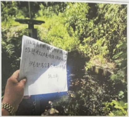
伊屯部落丹路二巷公墓前沉砂池清淤 施工前
