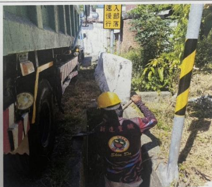
中心崙心崙路往部落水溝清淤 施工中
