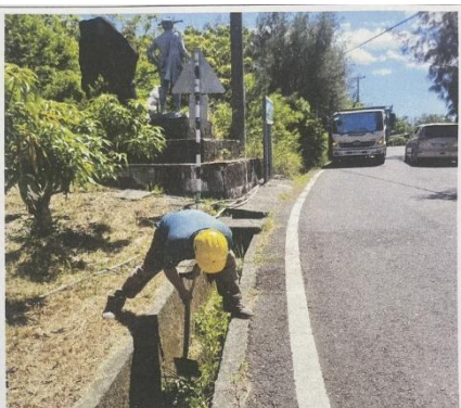
中心崙心崙路往部落水溝清淤 施工中
