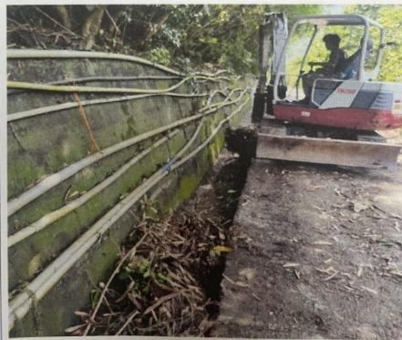
神鷹山產業道路側溝清淤 施工中
