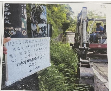
文源路側溝+集水井清淤 施工中
