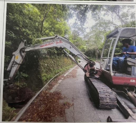
文源路側溝+集水井清淤 施工中
