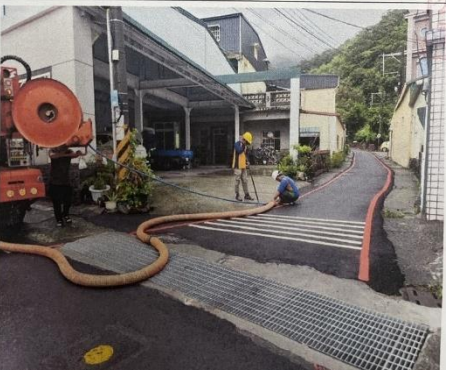
施工中 新路部落丹路四巷11號道路排水溝清淤
