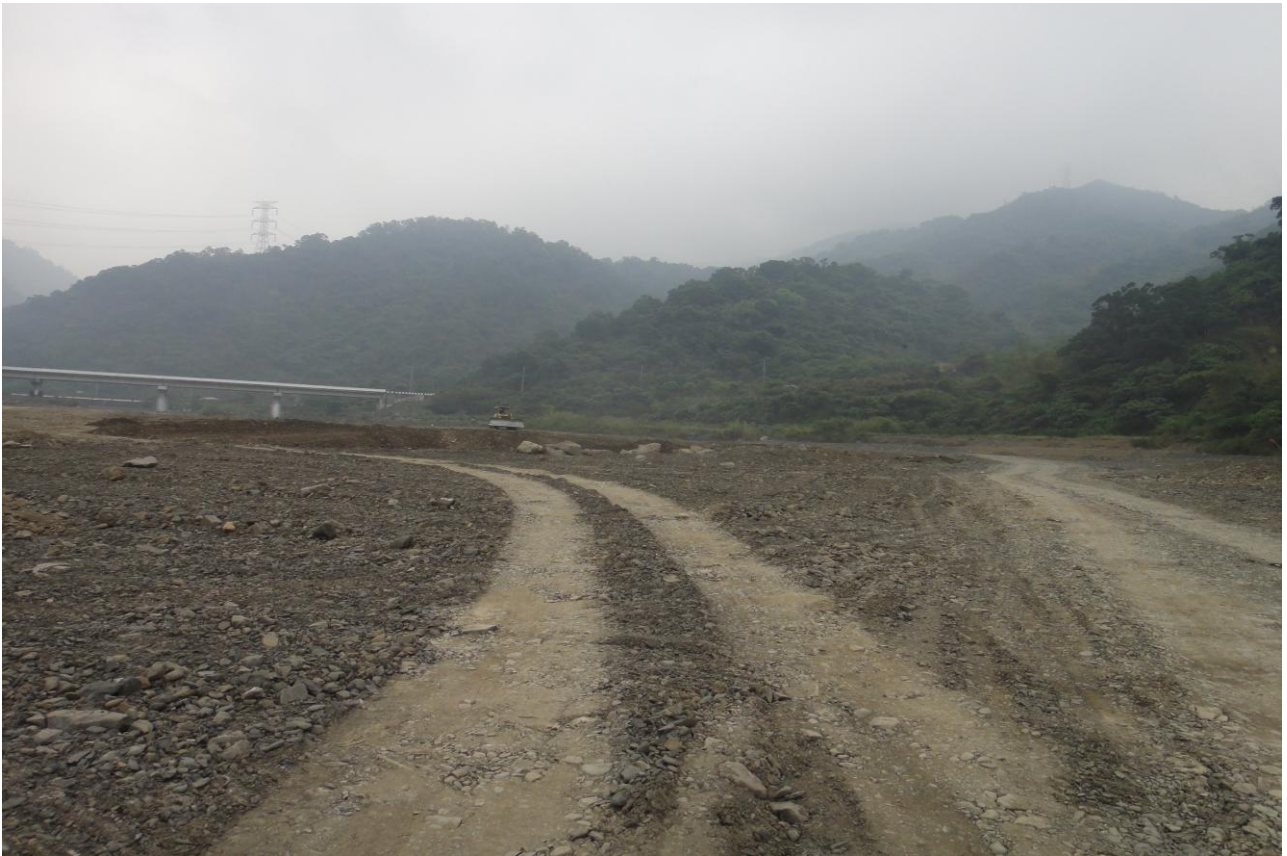
現場照片十一：草山橋下清疏狀況（下游）
