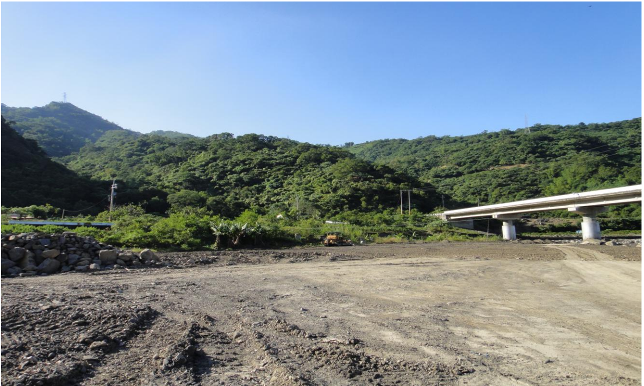
現場照片二：草山橋下清疏狀況（左岸）
