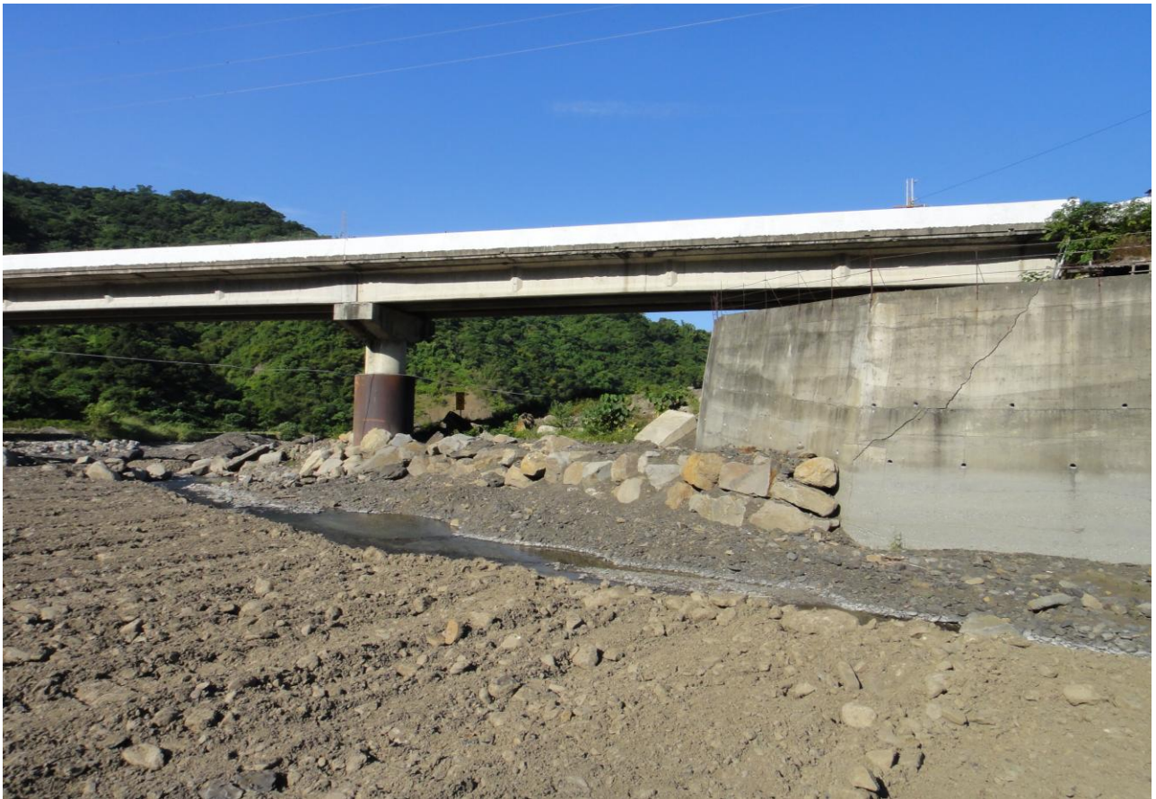
現場照片五：草山橋下清疏狀況（右岸）
