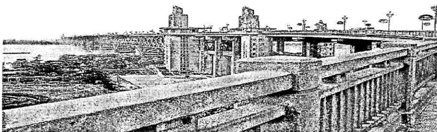
長江大橋完全是中國人的自主建造的雙層式鐵路、公路兩用橋具有歷史意義的偉大工程。始建於 1960 年，完建在 1968 年。南北兩端橋高 70 公尺分，上層的公路橋長 4589 米，車行道寬 15 米雙向兩道的汽車道，左右兩側的行人光觀道和機車道，下層則是火車軌道。南京長江大橋位於南京市西北面長江上，連通市區與浦口區，整座大橋如彩虹凌空江上，令人嘆為觀止。；下層的雙軌鐵路橋長 6772 米，寬 14 米，火車可同時對開。公路的雙孔雙曲拱橋形式，極富中國風特色。欄杆上嵌著鑄鐵浮雕，人行道旁白玉蘭花形的路燈，真是美輪美奐，內設有電梯通往鐵、公路橋及橋頭上的瞭望台。
